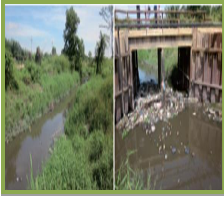
Gambar 1. Kondisi Sungai Pudu
